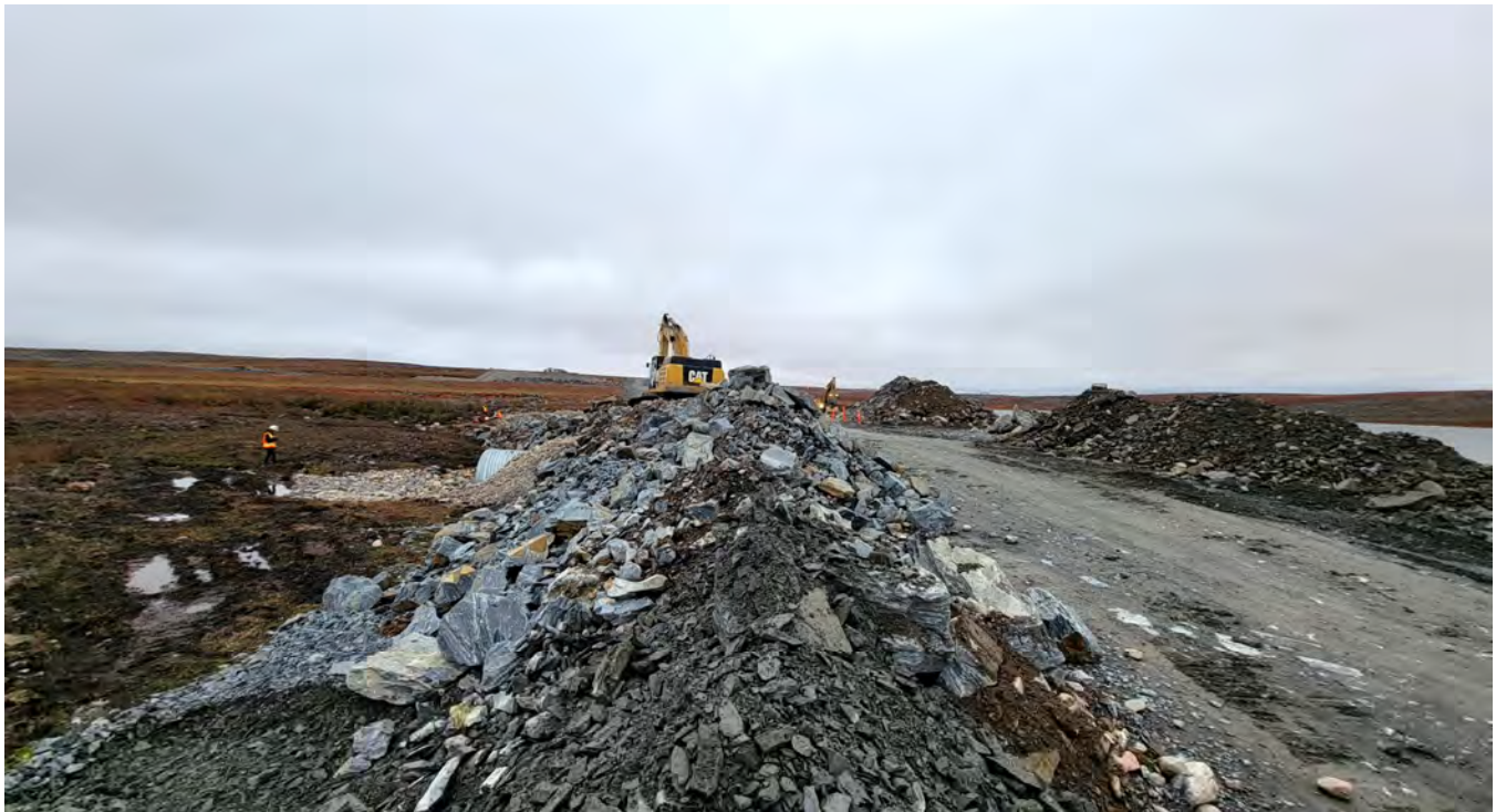
G-99. - Overculvert fill material.
