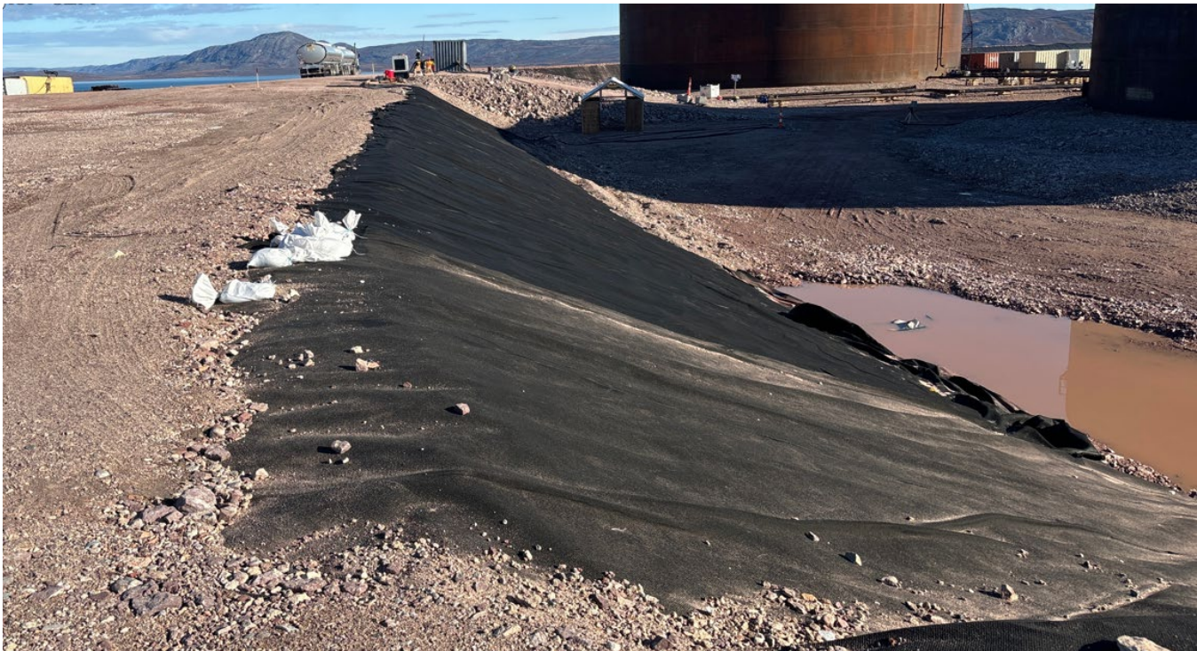
M-35: Liner backfill
