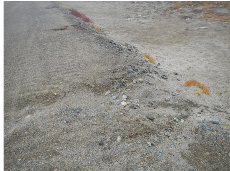
Lupin Dam 6 DS Minor Erosion
