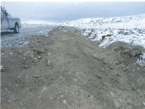
(10-16-2012)WD Dam – Till Placement
