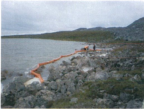
(08-28-2012)NP1 Sediment Barrier 1
