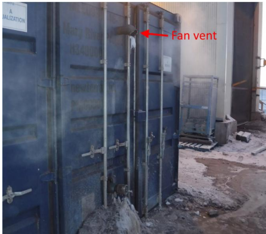
Photo 2. Fan vent discharge location.
