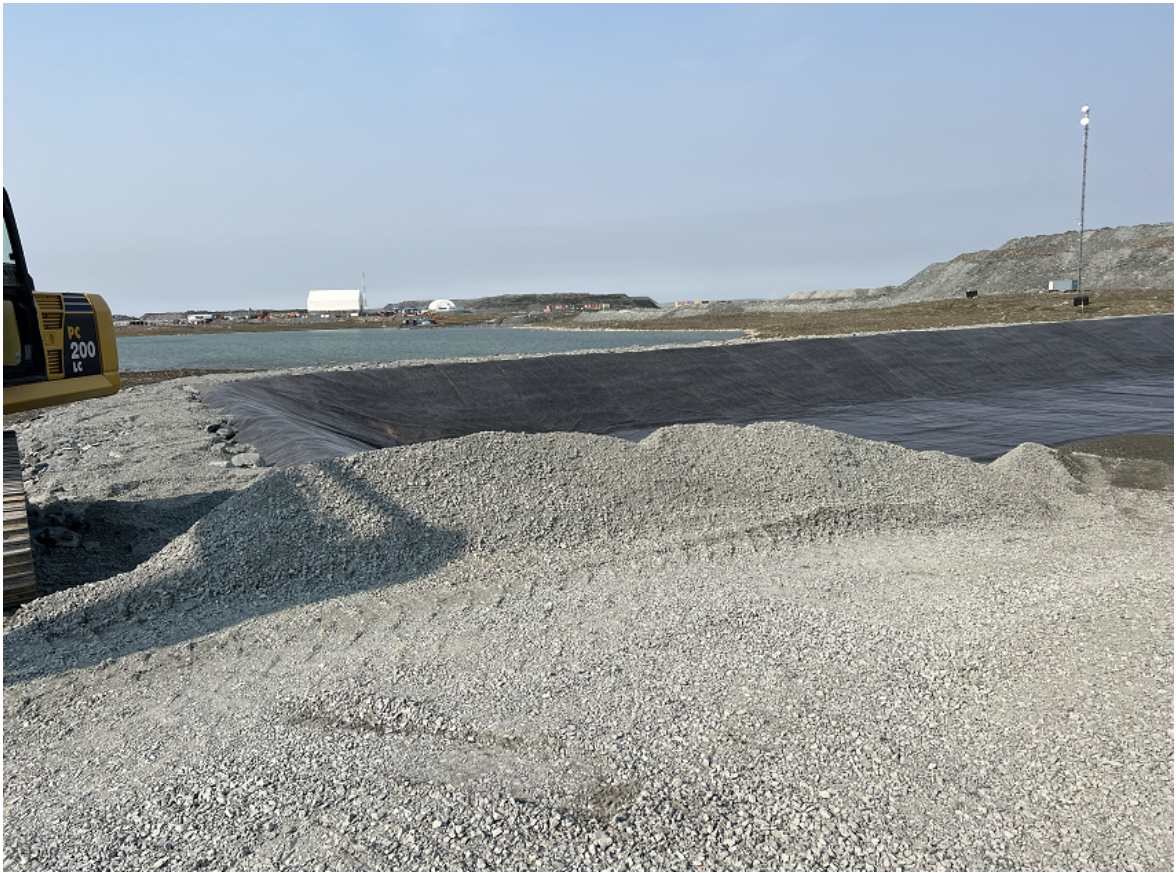
Geomembrane Installation
