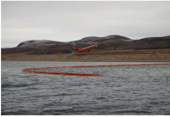
**Photo 3:** Deploying boom during Spill Exercise. **ላናት ህ**ላች 3: ፊል ላቴ ነ<ና ቴ⊿ል▷ሊ ላቴ ነው ነው ላላ? ውና ነር ነው በነር እላች.
