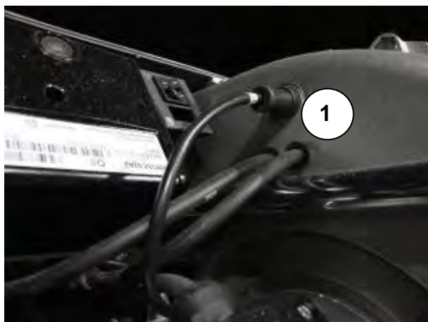
Primary Burner PE Cell
