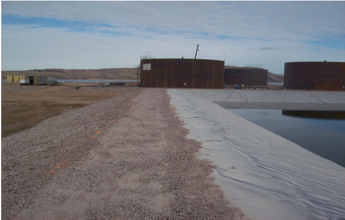
Effluent pond dyke.
