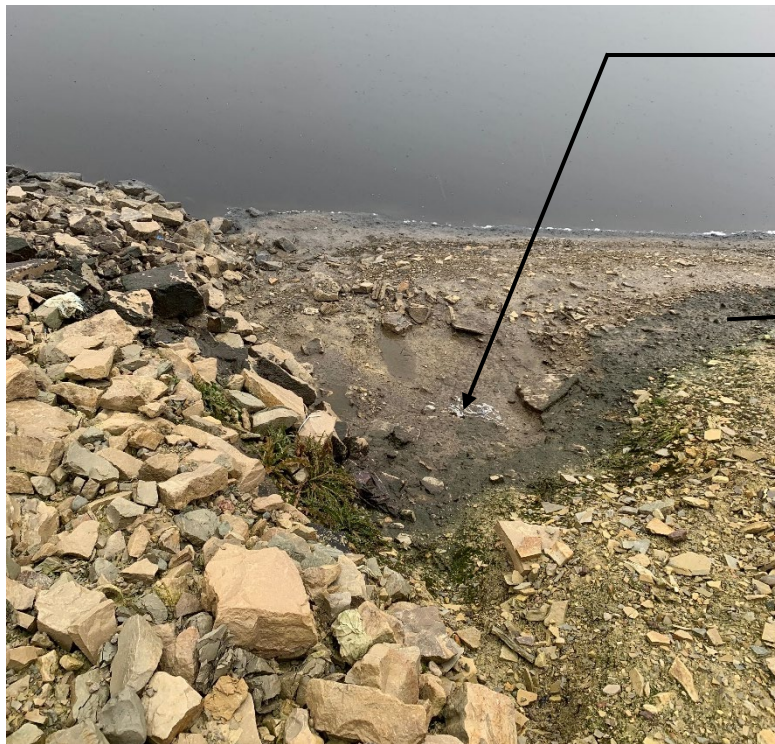
Local riprap damage
