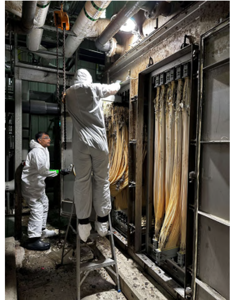
Removing Existing Membrane Module (0)
