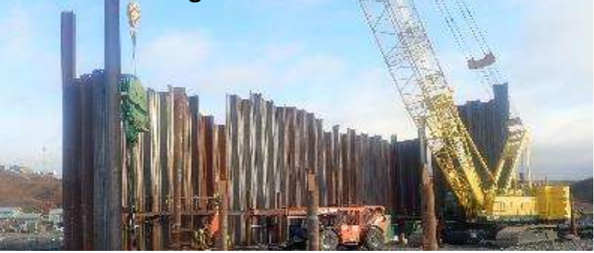
Vibro Pile Driving ስራ ስራ ስራ ስራ ስራ
