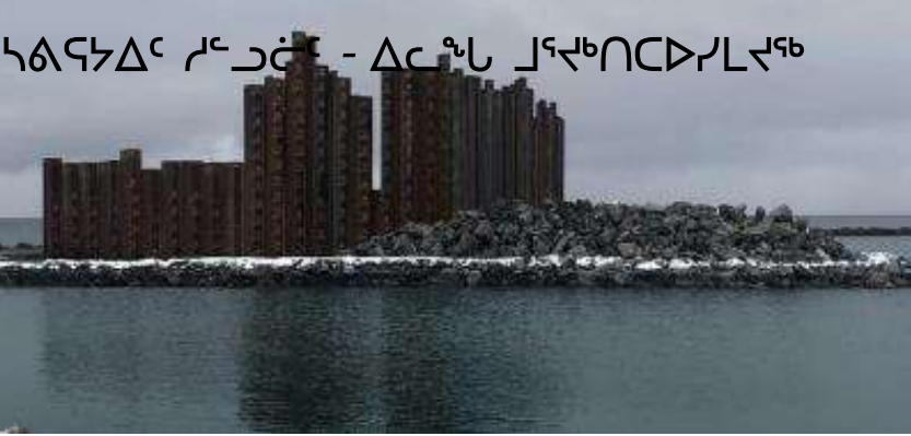
Sheet Piles—Partially Driven ካልፍለገልግ ስራ ስራ ስራ ስራ ስራ
