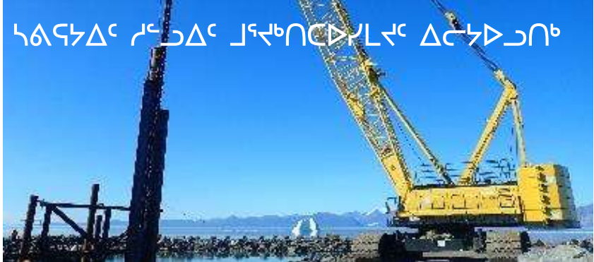
Sheet Pile Placement ካልፍለገልግ ስራ ስራ ስራ ስራ ስራ
