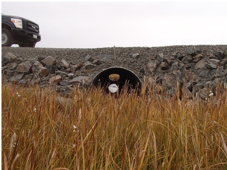
Photograph D1-19: R-04 km 12+050
